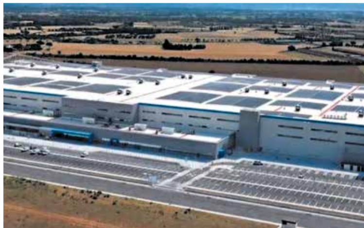
COMPLEX. Instal·lacions d'Amazon al Logis Empordà
