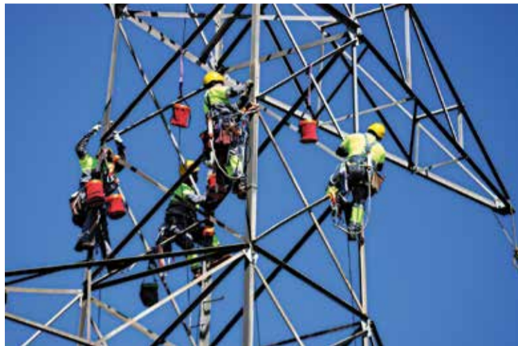
PAS A PAS. El primer que estan fent els operaris és retirar l'antic cablejat
