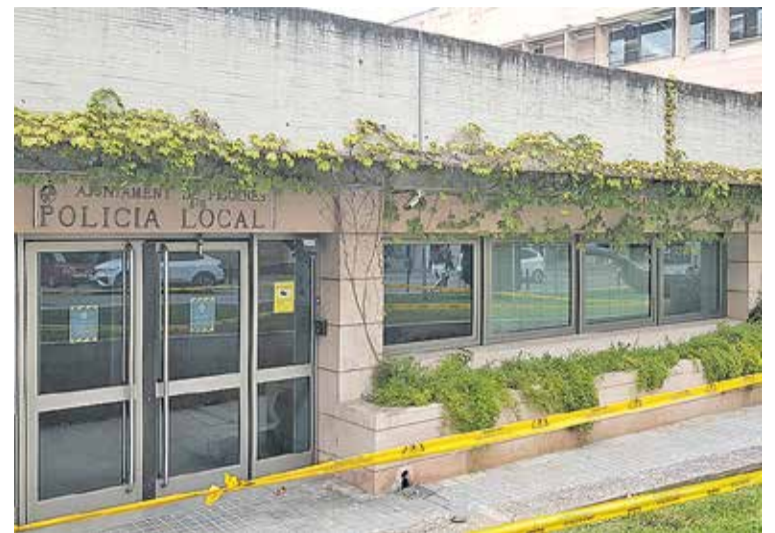
EN OBRES. Actualment s'hi està canviant tot el sistema de climatització ÀNGEL REYNAL
