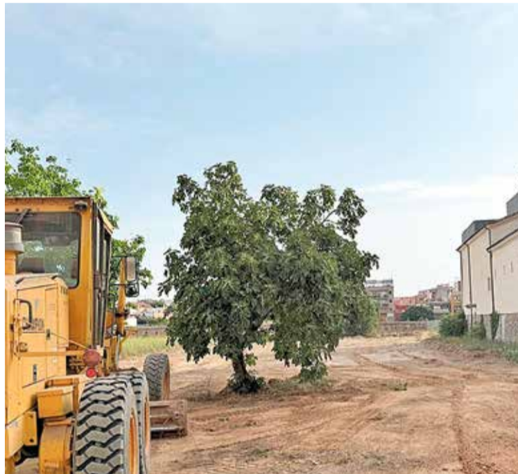
TREBALLS D'ADEQUACIÓ. S'han netejat i anivellat els diferents espais
