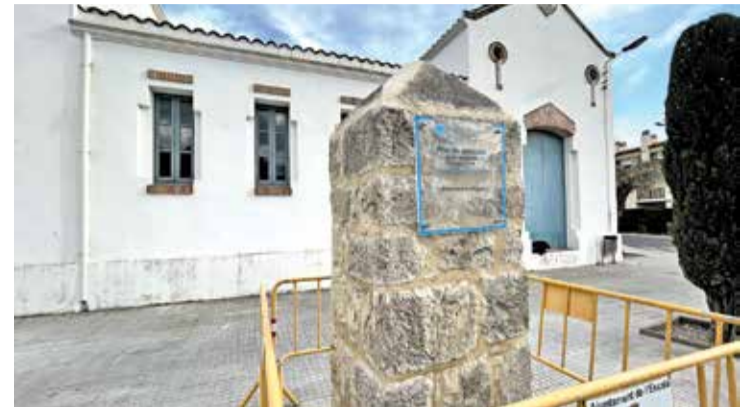
L'ESTRUCTURA. Formava part de la canalització d'aigua subterrània AJ. DE L'ESCALA
