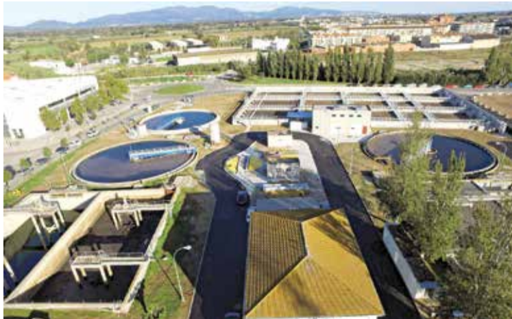
DEPURADORA DE FIGUERES. Cada dia hi entren 12.000 m 3 d'aigua
