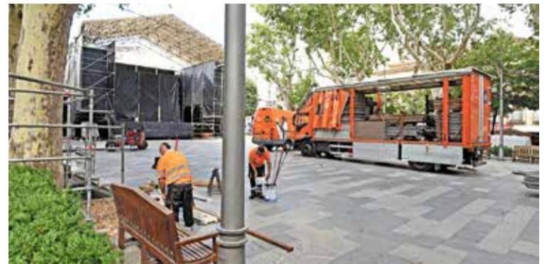
EN MARXA. Treballadors muntant la infraestructura a la Rambla ÀNGEL REYNAL
