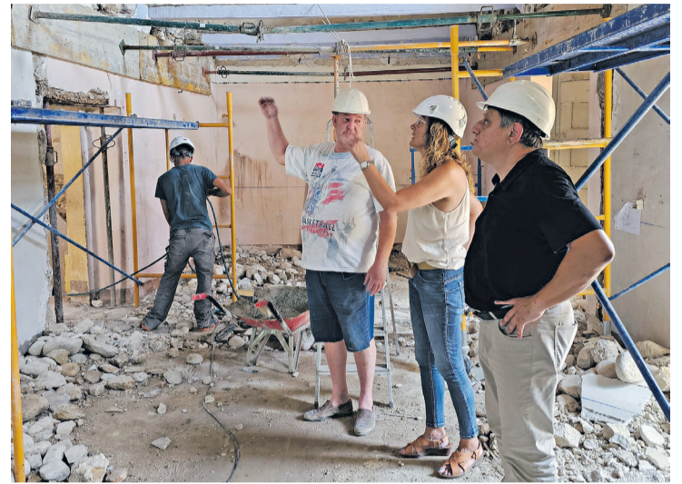
VISITA. De moment s'està consolidant l'estructura de l'edifici
