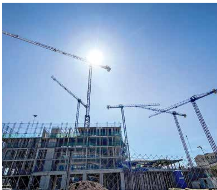
OBRES. Construcció d'un bloc de pisos, en una imatge d'arxiu
