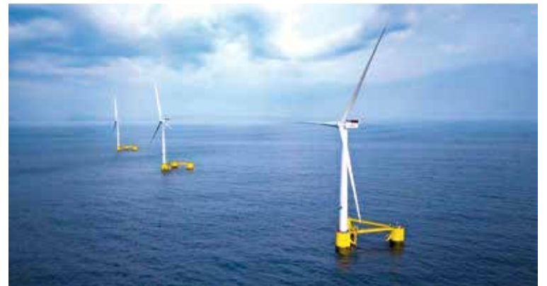
PARC EÒLIC MARÍ. Imatge d'una instal·lació de l'empresa Blue Fort Energy
