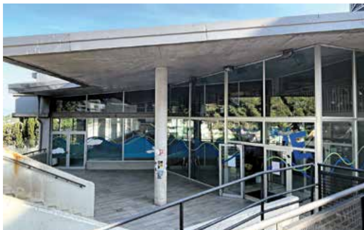
LES INSTAL·LACIONS. Només van estar tancades divendres
