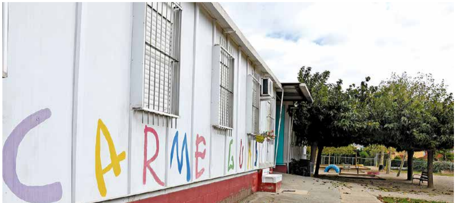
ESCOLA CARME GUASCH. L'equip de govern té previst el sobreseïment del contenciós administratiu per poder redactar tot seguit el projecte amb garanties
