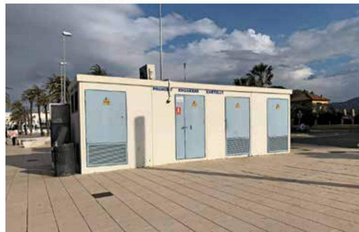
EBAR CENTRAL. S'està actuant en aquesta estació i a Santa Margarida
