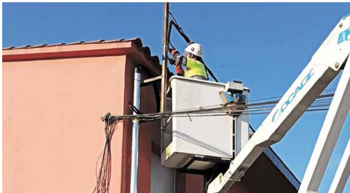
OPERARIS SOBRE EL TERRENY. S'han estès línies de baixa tensió i s'ha instal·lat un transformador nou
