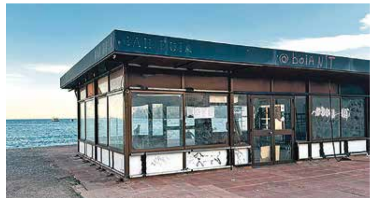
DESPRÉS DEL TANCAMENT. L'estructura del Boia s'ha anat degradant
