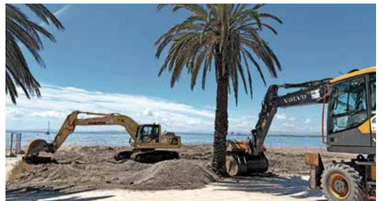
ROSES. Recta final de la reparació de la canonada d'aigües residuals G.VISA
