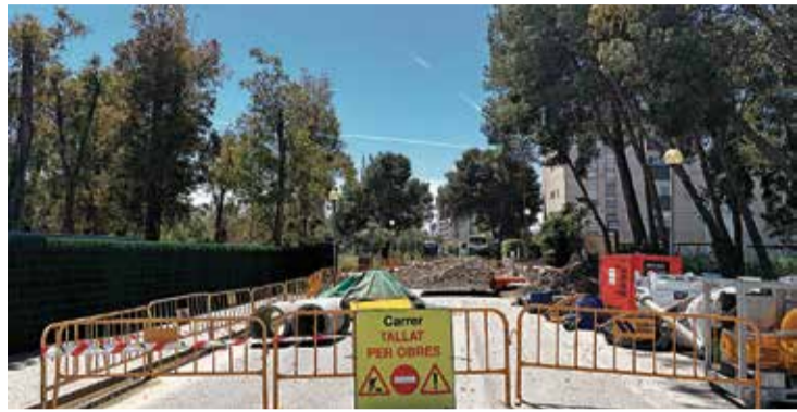
TREBALLS. Inici de l'obra pel carrer Port de Reig i també el de Cap de la Gola G.VISA
