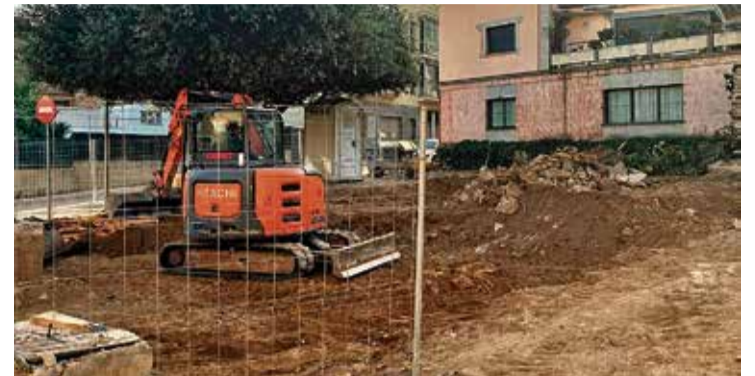
MÀQUINES SOBRE EL TERRENY. Les obres van començar la setmana passada
