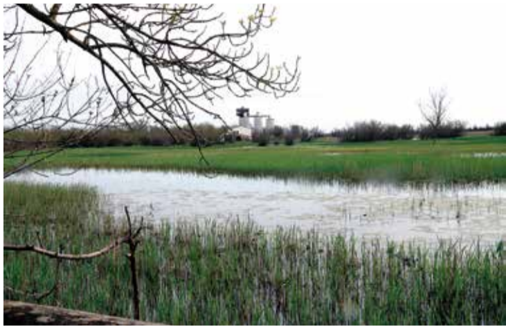
ESTANYS DEL MATÀ. En construcció un cargol d'Arquimedes a la zona oest G. TUBERY
