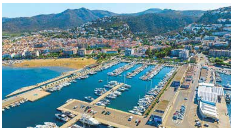
LES INSTAL·LACIONS. Molt properes al Parc Natural del Cap de Creus
