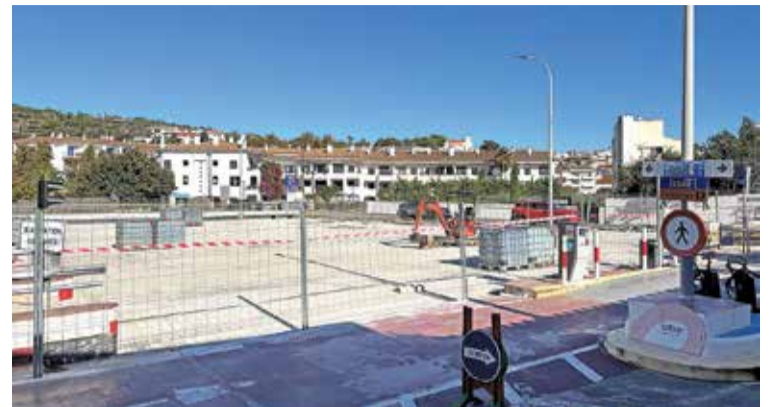
APARCAMENT DE LA RIERA DE SANT VICENÇ. La zona amb els treballs en marxa GV
