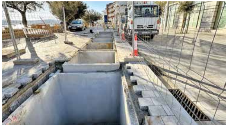
AQUEST NOVEMBRE. Ja es podran instal·lar els contenidors soterrats AJ. L'ESCALA
