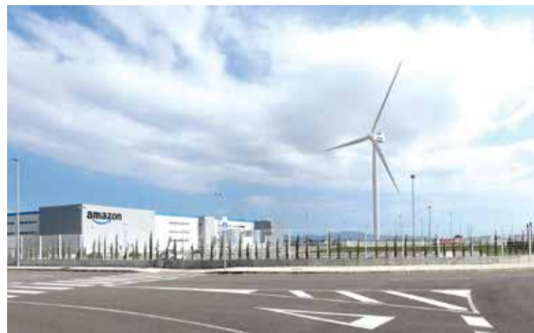
RECREACIÓ DEL PROJECTE. L'aerogenerador tindrà una alçada de 126 metres AMAZON
