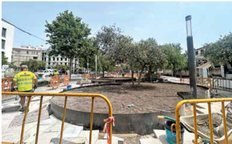
PRIMERA FASE DE LES OBRES. Es complementarà passat l'estiu
