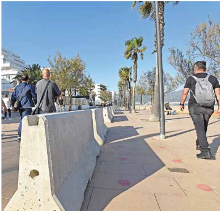
ELS NEW JERSEY. Els blocs de formigó que delimitaran les terrasses
