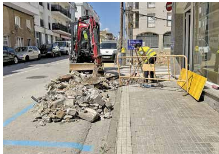
MÀQUINES SOBRE EL TERRENY. Han començat per l'avinguda Ave Maria
