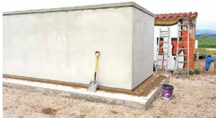
DIPÒSIT MUNICIPAL. S'ha instal·lat, netejat i desinfectat
