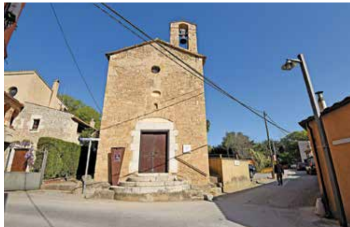
BORRASSÀ. L'Ajuntament espera l'autorització per construir un dipòsit À. REYNAL
