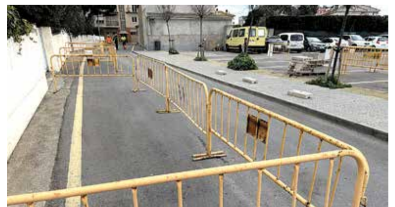
SENYALITZACIÓ INSTAL·LADA. Les obres es faran des d'ara fins al Carnestoltes
