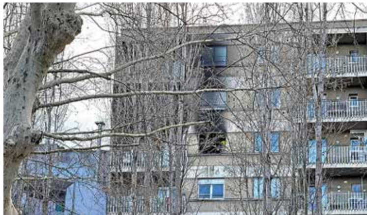
EDIFICI DE VUIT PLANTES. El pis sinistral ha quedat inhabitable
