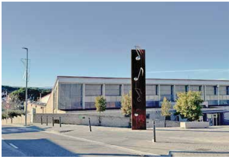
PAVELLÓ MUNICIPAL. Aquest any es renovarà tota la coberta
