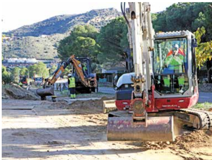
ELS TREBALLS. Les obres, iniciades recentment, s'allargaran tres mesos
