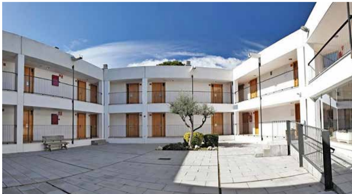
L'EQUIPAMENT. Les actuacions se centraran sobretot en la millora dels sistemes de climatització
