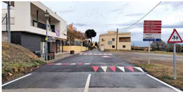
REPAVIMENTACIÓ. Entre l'ajuntament i el carrer Balcó de l'Empordà AJ. DE GARRIGÀS
