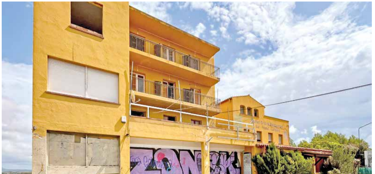
A TOCAR DE L'N-II. Les instal·lacions de l'antic càmping estan tancades des de fa gairebé 20 anys i durant aquest temps hi ha hagut assalts i vandalisme
