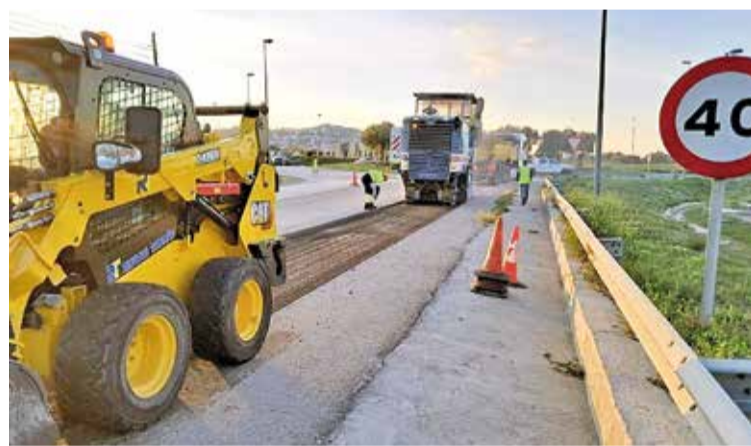
OBRES A LA GI-610. Afecten Roses, Palau-saverdera, Pau i Vilajuïga
