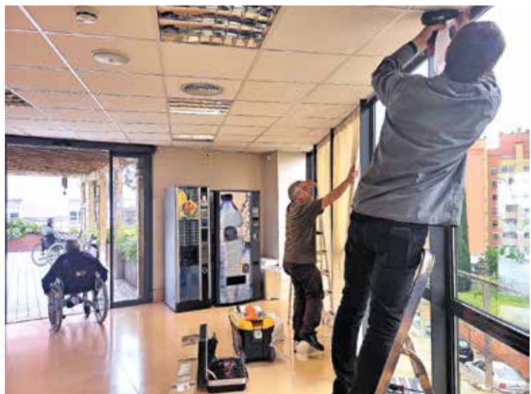
EN ACCIÓ. Operaris instal·lant cortines a la primera planta del centre
