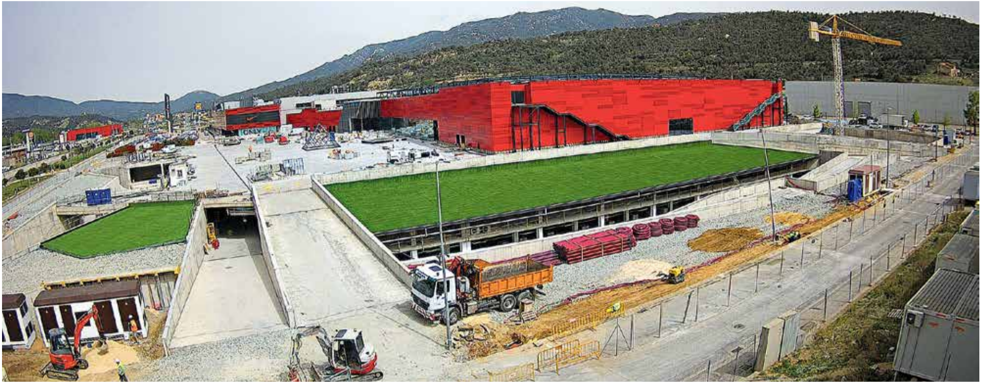
TRAM FINAL DE LES OBRES. L'ampliació ha permès construir 25.300 m 2 de superfície comercial per arribar als 58.300, i 52.500 m 2 més d'aparcament per arribar als 71.500
