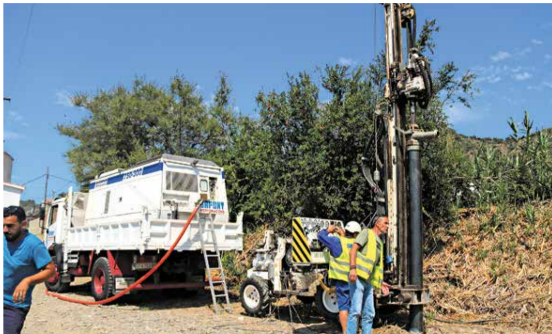
EL POU NOU. Els operaris treballant en l'obertura del tercer pou del Port de la Selva
