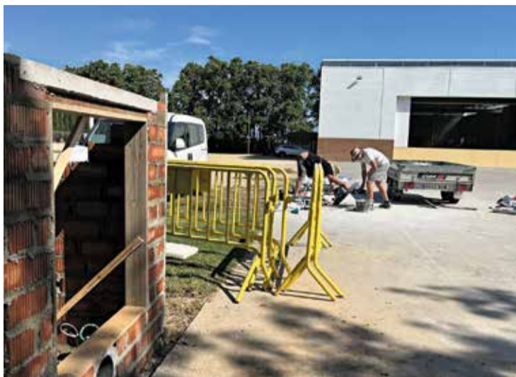
EN PLENA TASCA. Operaris treballant la setmana passada
