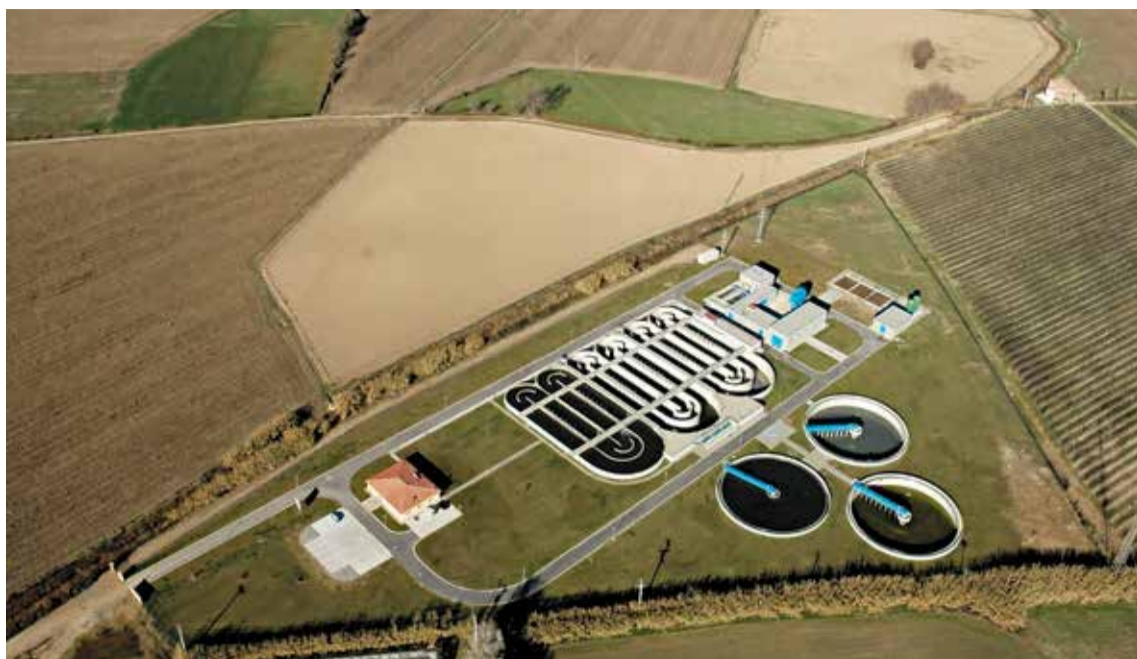
L'EDAR DE L'ESCALA. La depuradora està gestionada pel Consorci d'Aigües Costa Brava Girona
