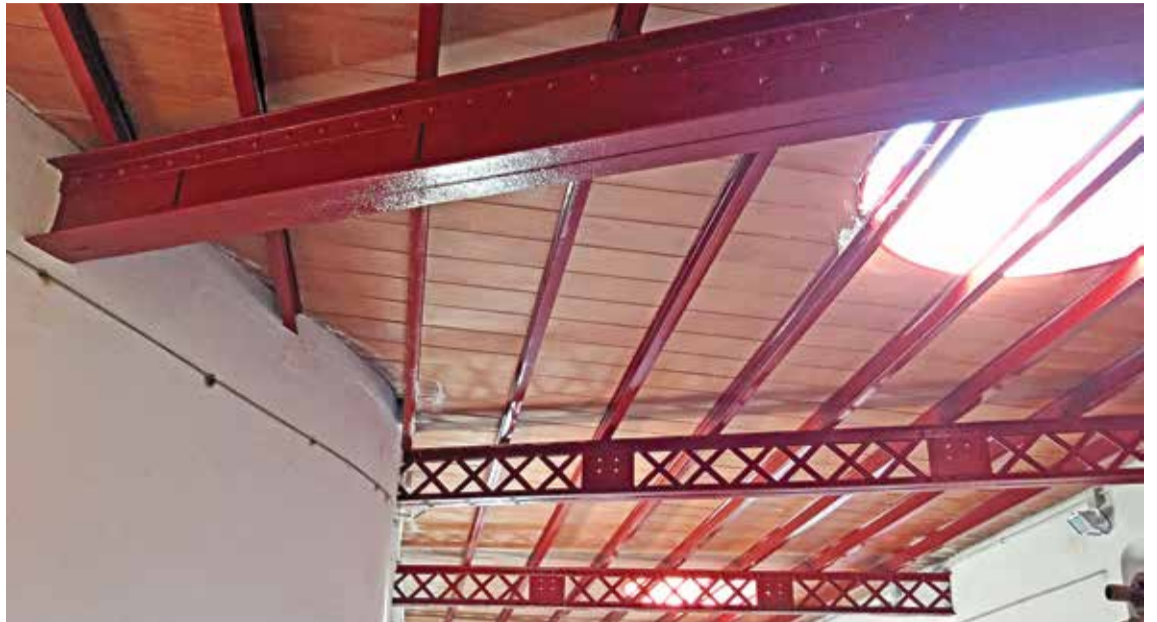
EL TRULL DE LA SELVA DE MAR. Una rehabilitació amb les bigues de ferro en perfecte estat de conservació
