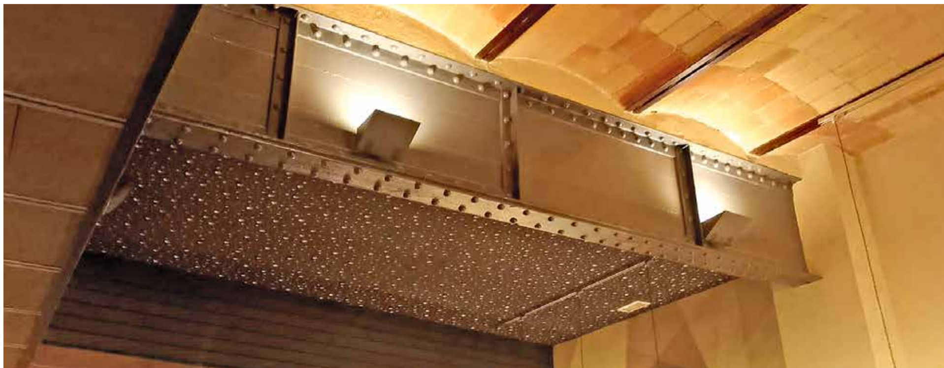
AL NÚMERO 30 DEL CARRER NOU DE FIGUERES. Bigues amb reblons i entre retxades que formarien part de la construcció d'unes antigues cotxeres
