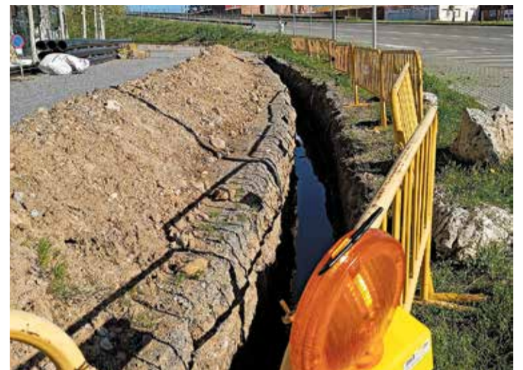
A FIGUERES. La rasa oberta davant de la depuradora de Figueres
