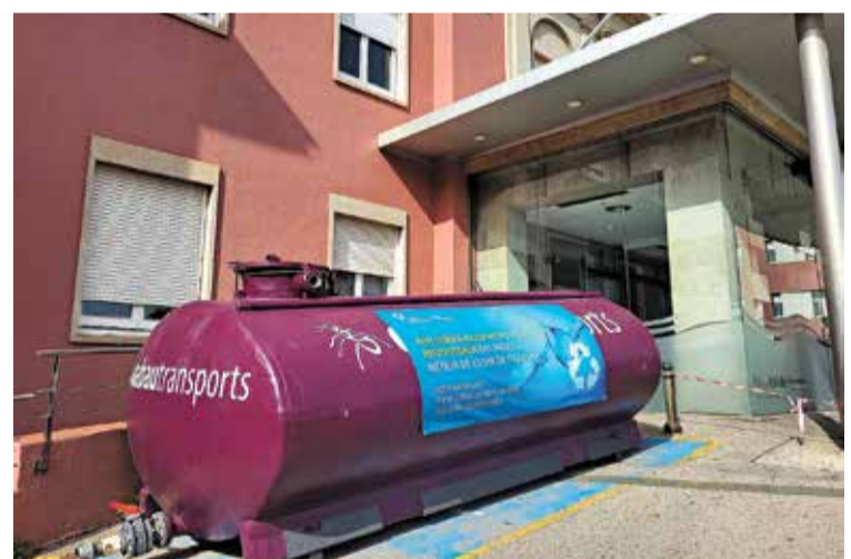
DIPÒSIT D'AIGUA REGENERADA. L'utilitzen per netejar la façana de l'hospital
