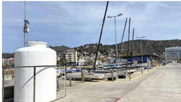
AIGUA RECICLADA. Nou dipòsit per fomentar l'estalvi d'aigua A.J. ROSES
