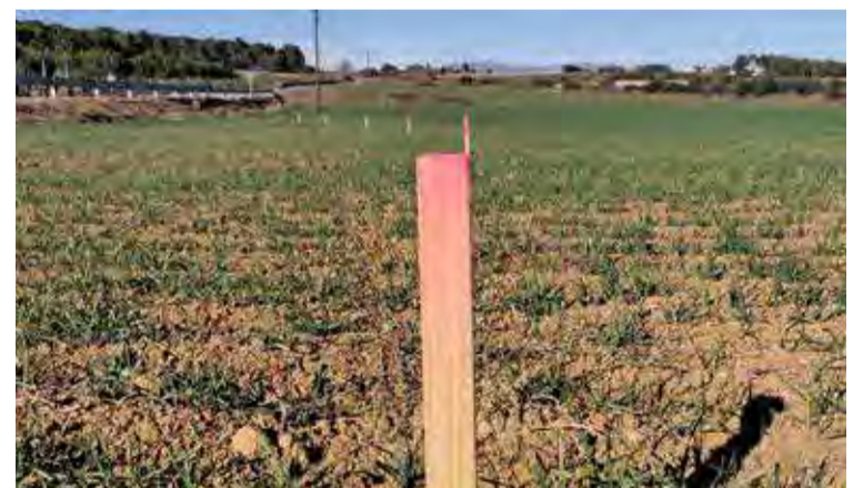
ESTACA. Treballs previs de replanteig de les obres per fer la via verda AJ. GARRIGÀS
