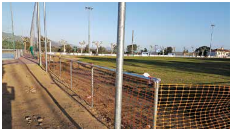
TREBALLS EN MARXA. El camp quedarà enganxat a la pista annexa
