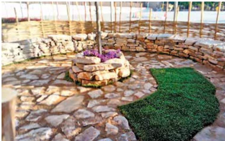
CONSTRUCCIÓ. Una mostra d'un banc construït amb pedra seca
