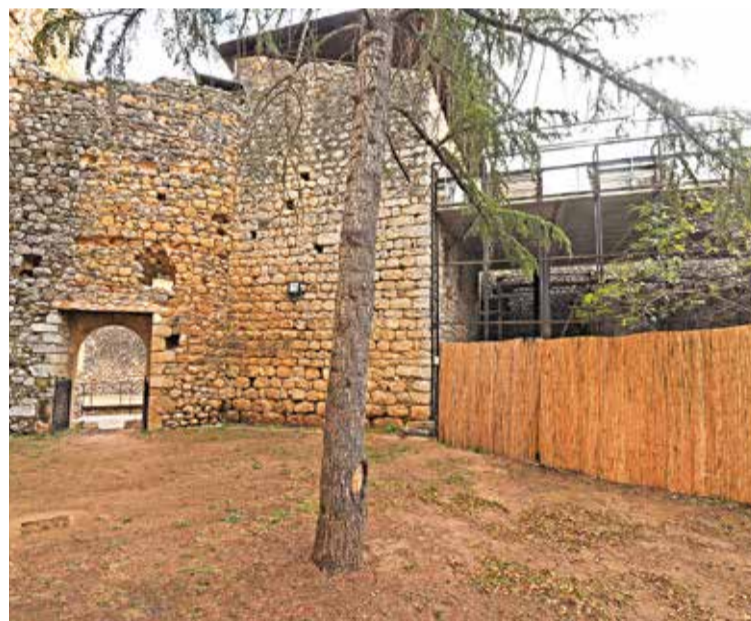
EL LATERAL. Imatge des del patí interior i les obres de remodelació
