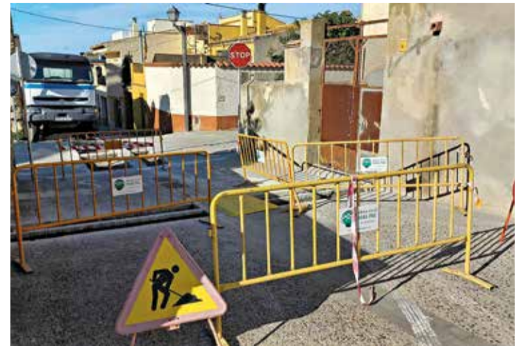
REPARACIONS AL PAVIMENT. Els treballs van començar la setmana passada AJ.P.S.
