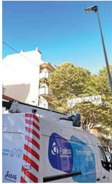
CARRER NOU. Treballs en marxa A.J.FIG
