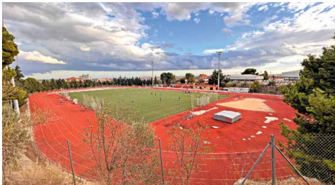
ESTADI ALBERT GURT. La imatge constata l'estat de deteriorament del paviment de les pistes d'atletisme
