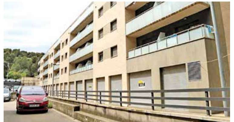
AVDA. PERPINYÀ. Edifici de gran tenidor amb pisos adquirits per l'Ajuntament
