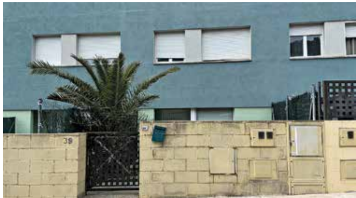
DESHABITADA. La Policia Local va tornar a precintat l'immoble
