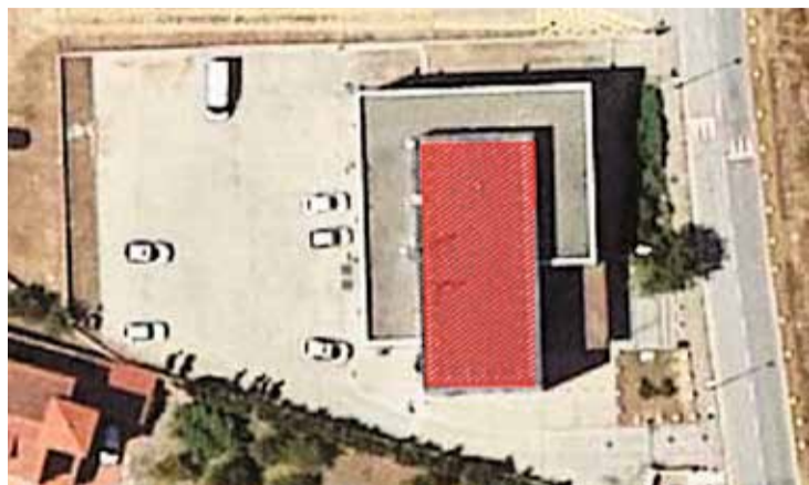
MOSSOS D'ESQUADRA. La coberta tindrà un total de 18 mòduls
