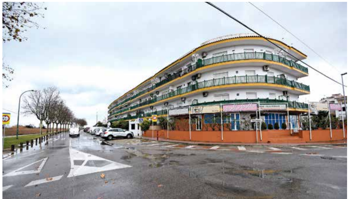
UN SECTOR PENDENT DE MODERNITZACIÓ. La idea de l'Ajuntament és reurbanitzar-lo tot
